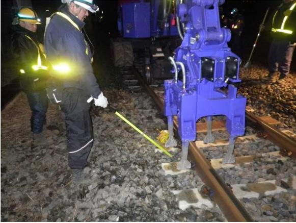
BHに特殊な機械を取付け、通常は人力で軌道整備を行います。機械を使用して作業員の負担軽減を図っております。
