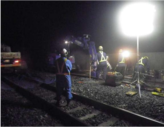
列車が毎日走っていると碎石が小粒になったり、雨水が溜まって噴泥したりして車の乗り心地が悪くなる原因となります。そうした箇所を直すために重機械(BH)を使用して碎石の交換を行います。
