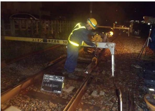
列車はレールの上を走ります。レールの損傷や摩耗など列車が通過した年数によってはそのままにしておくと脱線事故に繋がりがねないので、年間を通じてレール交換を行っています。一晩でレール交換する長さは最長で400mの交換を深夜、列車が走らない約2時間で行っています。
