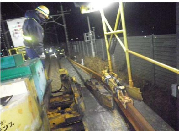
特殊な列車を使用して長尺レール(1本150m)を線路に卸していきます。
