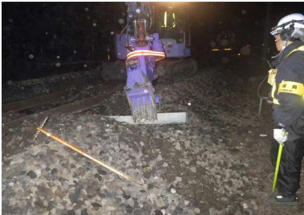
レールを固定しているマクラギはコンクリート製となり、耐久年数も以前の木マクラギより数段と上がっています。老朽化したPCマクラギは順次マクラギ交換を行い、交換作業につきましては人力で行う場合と重機を(BH)使用して行う二通りの施工方法があります(写真は重機による交換作業です)。
